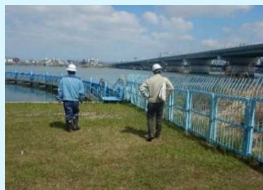
合同点検（現地）
